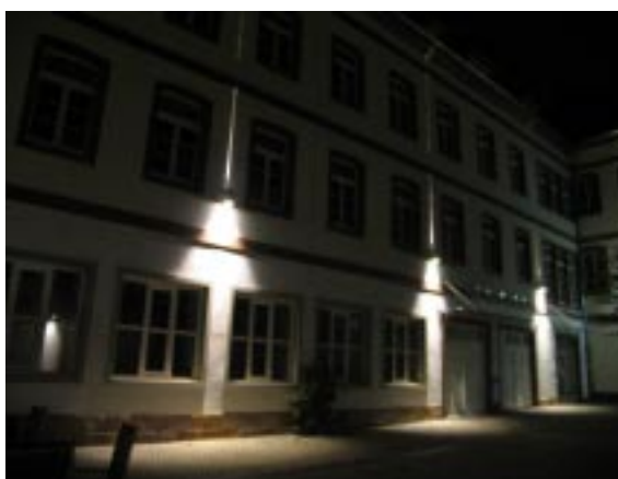
Momentane Beleuchtungssituation mit abstrakten Lichtfiguren
